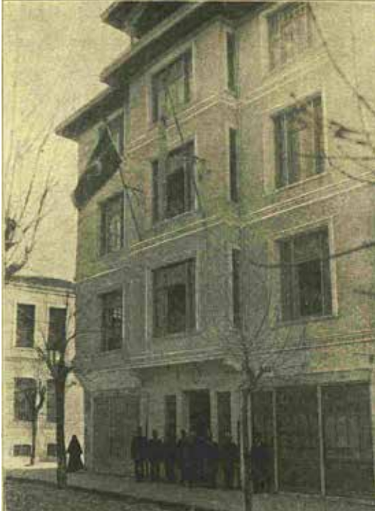
Osmanlı Hilâl-i Ahmer Cemiyeti Merkez-i Umumi binası
