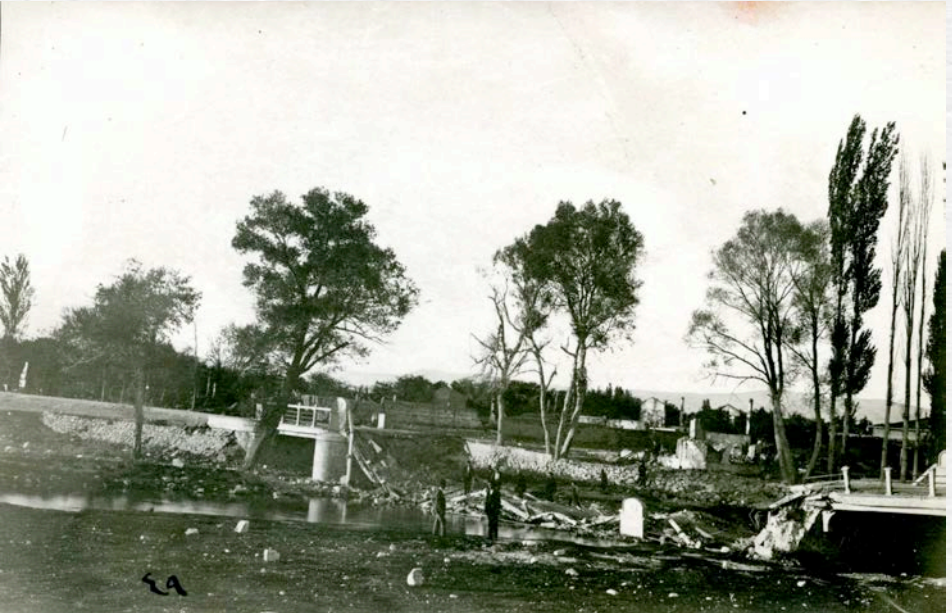
■ Yunan ordusunun çekilme esnasında Kütahya'da yıktıkları bir köprü.
