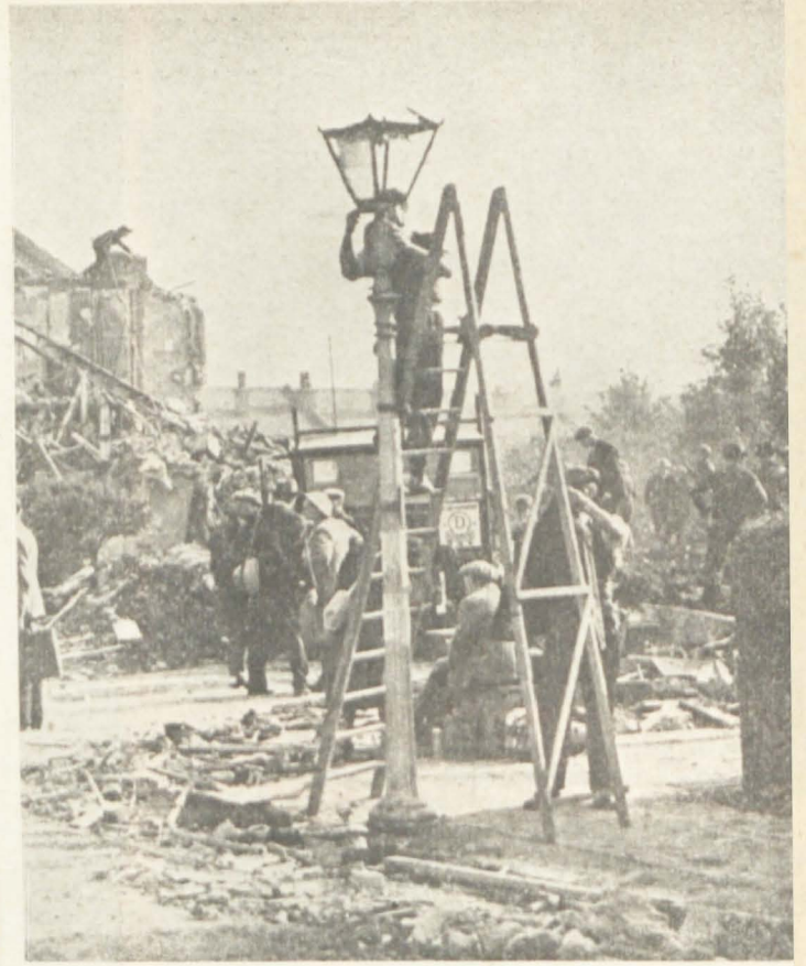
Bombardımandan sonra sokaklarda faaliyet. İşçilerden bazıları havagazı lâmbalarını tamir ederken ötekiler de yollardaki çukurları ve yıkılan bir binayı tetkik ediyorlar
