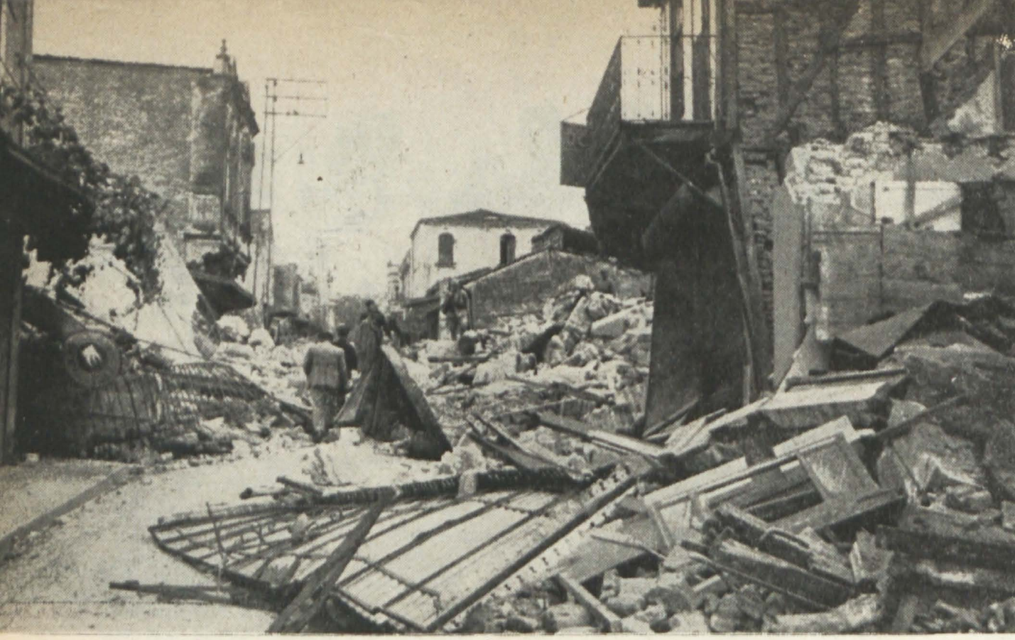
Adapazarında harap o- lan mahallelerden biri
