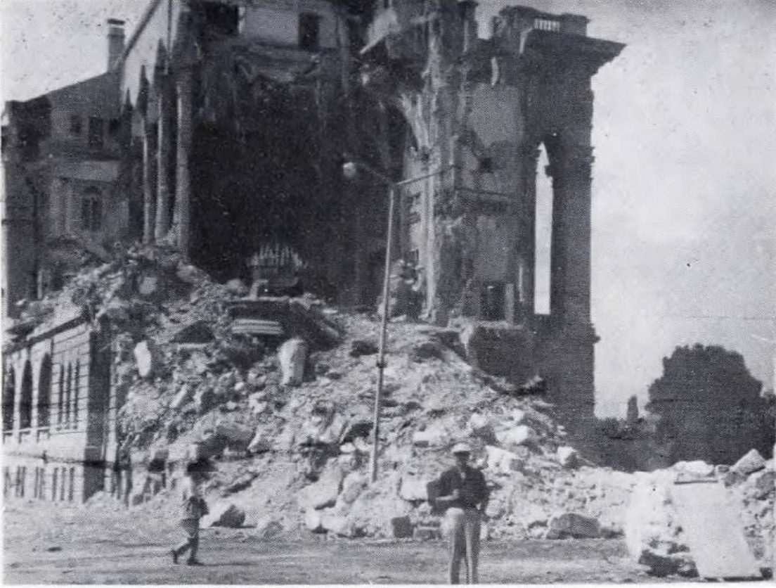
Bu, yarısı yıkılmış bina eskiden bir cami idi. Yugoslavlar onu evvelâ kilise, daha sonra da ordu evi haline getirmişler. Son depremde en çok harap olan binalardan biri de bu bina olmuştur. Halen devam eden depremlerden sonra da binadan geriye ne kalacağını kestirmek tabii mümkün değil...
