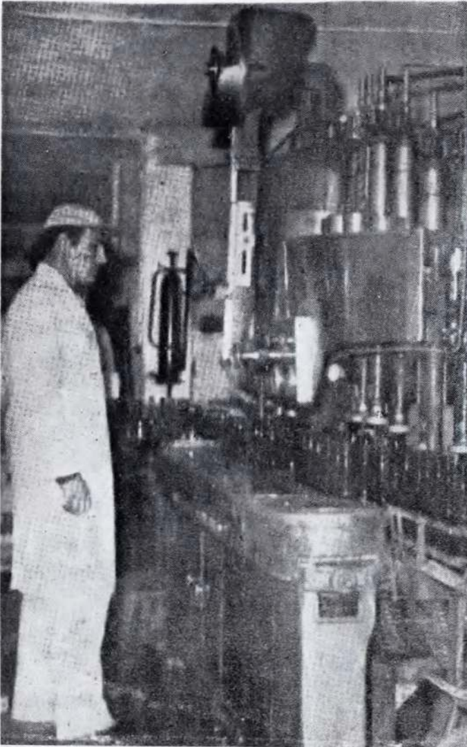
Otomatik şekilde el değmeden dolan şişeler kuvvetli ışık önünde tek tek kontrol edilir
