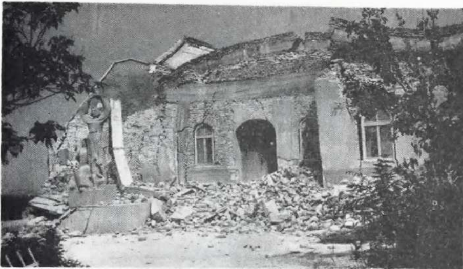
İşte, binlercesi yıkılan binalardan biri. Bu kilise binasının da çatlamadık yeri kalmamış. Nerede ise tamamı çökecek. Yalnız bir şey ayakta duruyor. İnsanlığın timsali..
