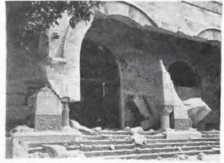
Harabeye dönmüş bir kilisenin önü ve yıkıntıların hali.
