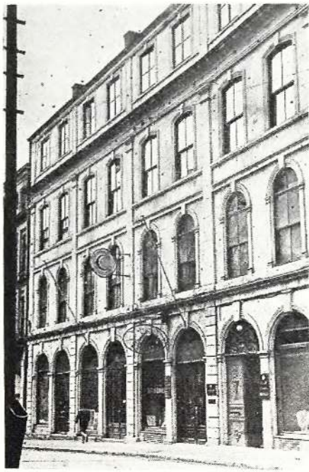
Kızılay Konya Şube binası.
