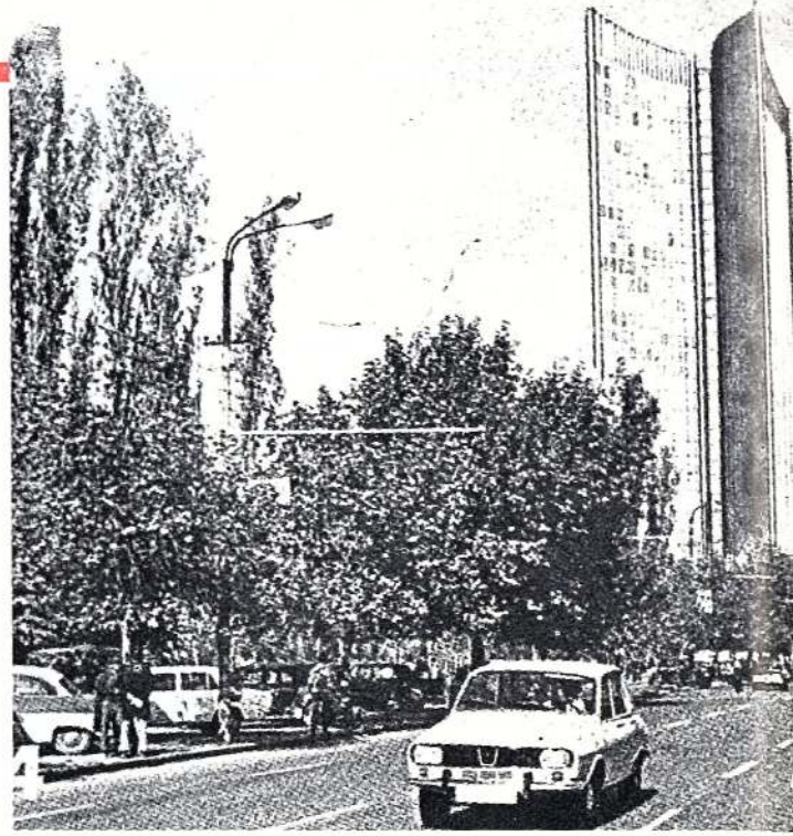
Kızılay'da inşa edilecek Orta Doğu ve Balkanların en yüksek binası. Resim, Bakanlıklar istikametinden çekilmiştir ve sağda
