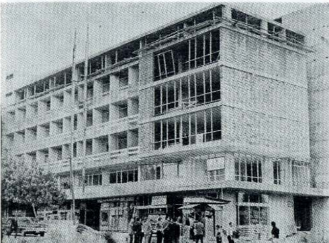
Kızılay Ankara Şubesinin bitmek üzere olan Yeni Binası.
