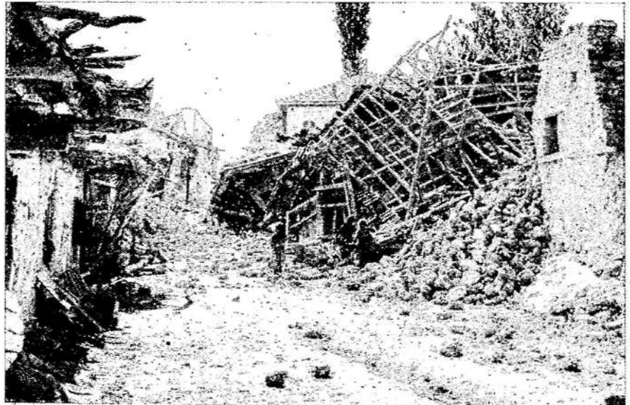
Burdur'da depremin virane haline getirdiği bir mahalle.
