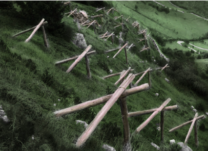
◀ Şekil 15: Aktif Kalıcı Önleme Yöntemlerinden Tripod (Üçayak)
