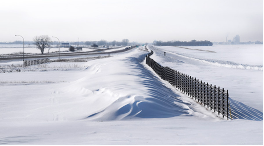
▲ Şekil 18: Aktif Kalıcı Önleme Yöntemlerinden Kar (Rüzgâr) Perdeleri
