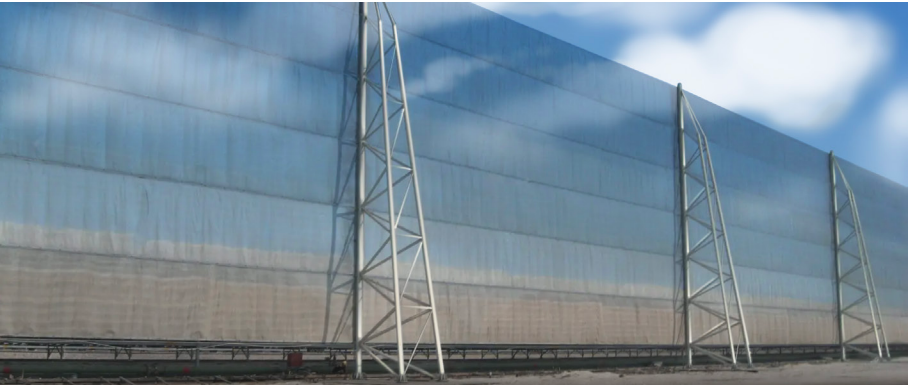
▲ Şekil 19 : Aktif Kalıcı Önleme Yöntemlerinden Rüzgâr Çatıları
