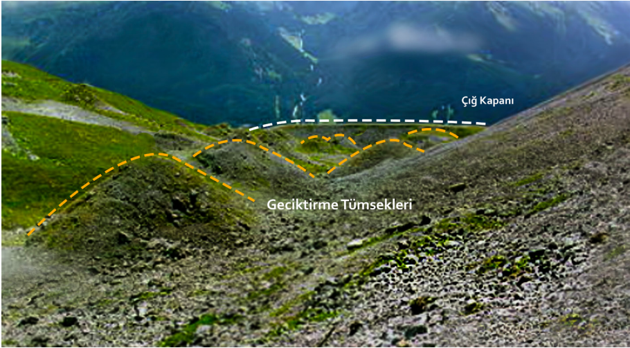
Şekil 24: Pasif Kalıcı Önleme Yöntemlerinden Geciktirme Tümsekleri ve Çığ Kapanı
