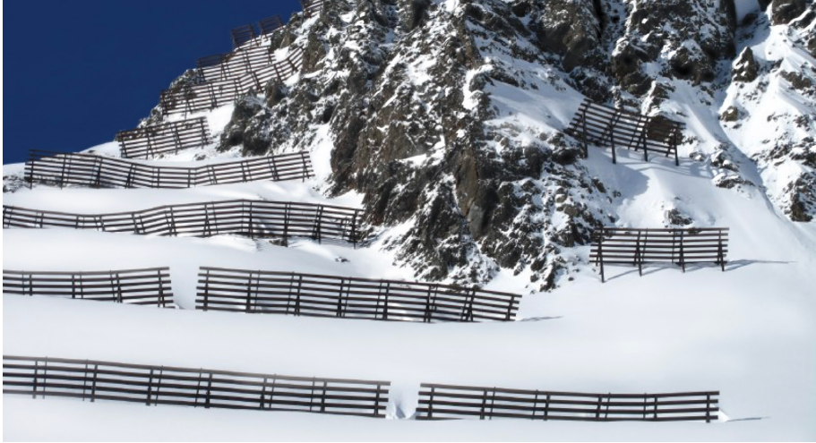
▲ Şekil 16: Aktif Kalıcı Önleme Yöntemlerinden Kar Çitleri
