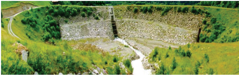
▲ Şekil 22: Pasif Kalıcı Önleme Yöntemlerinden Çığ Barajları
