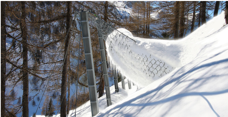
▲ Şekil 17: Aktif Kalıcı Önleme Yöntemlerinden Kar Ağları
