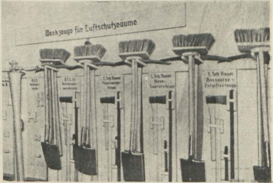
Yer altında hazırlanmış alât ve edevat ve gaz temizleme deposu
