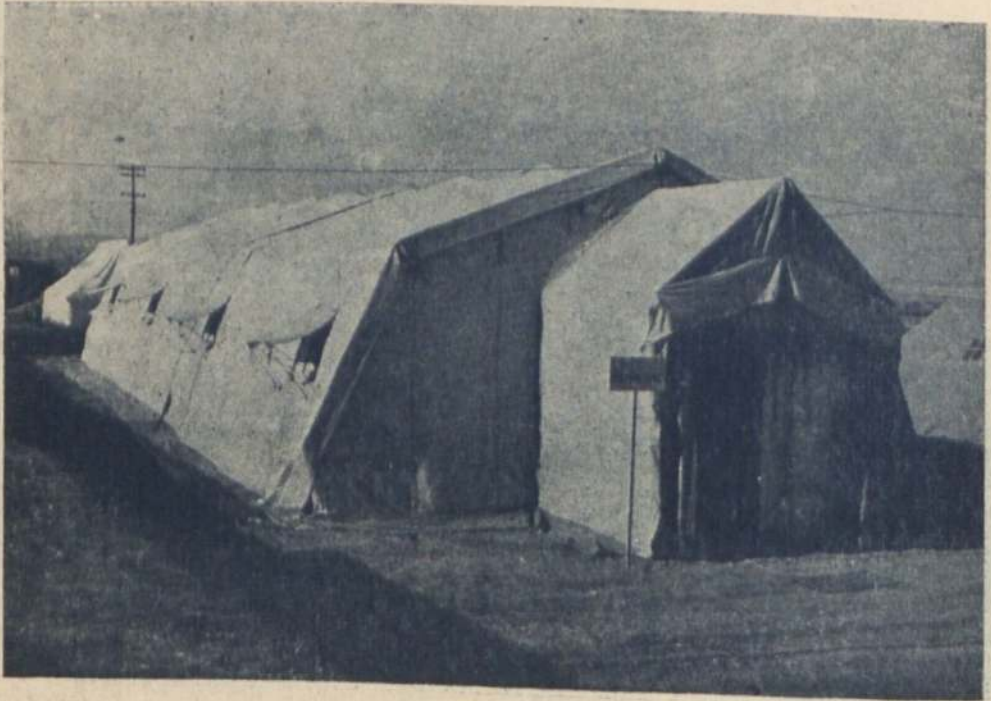
Demir iskeletli Seyyar Harp hastahanesi Ameliyathane çadırlarından biri.
