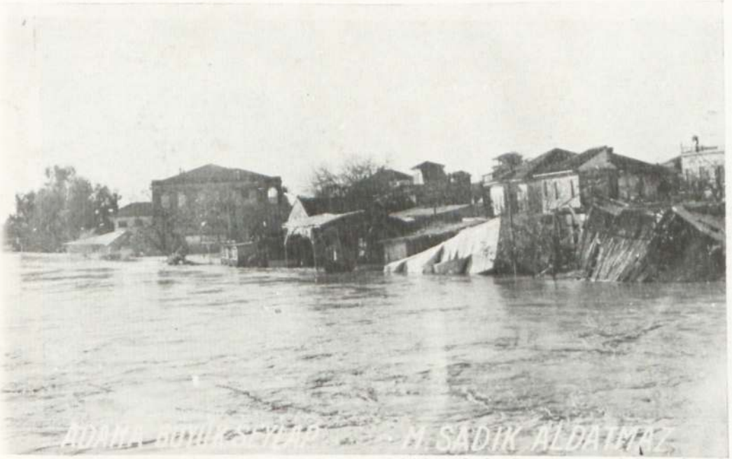
Yukarda : Setleri yıkan ve Reşadiye mahallesini kaplayan sular Aşağıda : Suların hücumıyla yıkılan evlerin acıklı görünüşü
