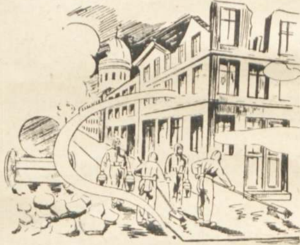
Gaz altında çalışan gaz temizleyiciler.
