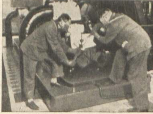
Gaz altında tamir yapan teknik tamir gurubu
