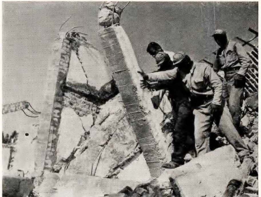
Adapazarı'nda yıkılan bir binanın enkazı altında kalanlar olup olmadığı araştırılıyor.
