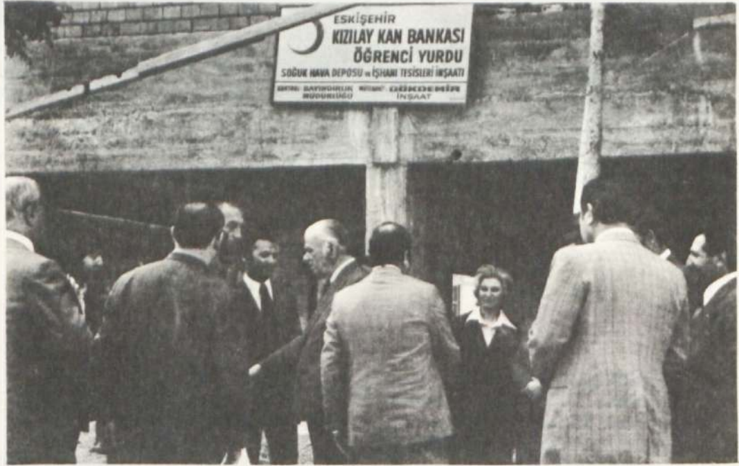
İnşaatı tamamlanmak üzere olan Eskişehir Kızılay binası
