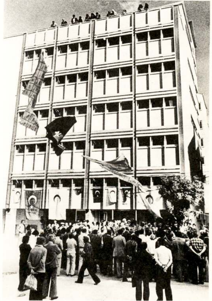
Eskişehir Rant ve Sosyal Hizmetler tesisinin cepheden görünüşü.
