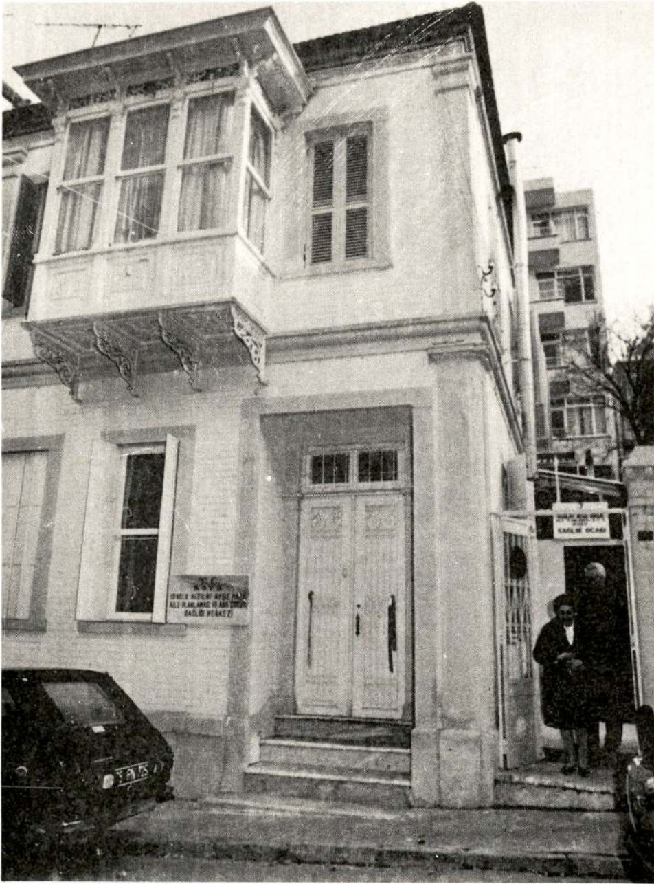
Emekli öğretmen Leman Başa'nın bağışı olup Kızılay tarafından restore edilen. "Kızılay Ayşe Başa Aile Planlama Ana Çocuk Sağlığı Merkezi ve Sağlık Ocağı binası. (Güzelyalı-Göztepe)
