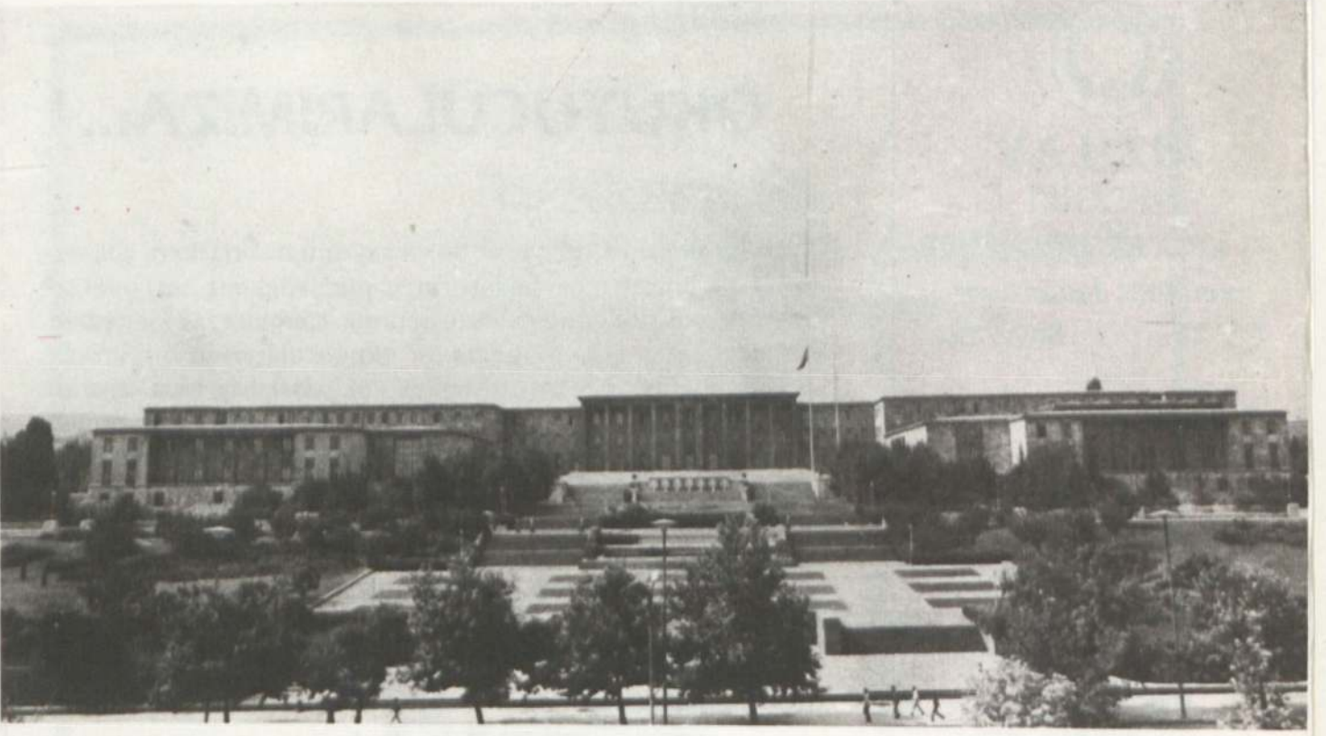
TBMM binasının genel görünüşü
