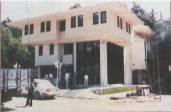
Göynük Kızılay Şube Hizmet Tesisi
